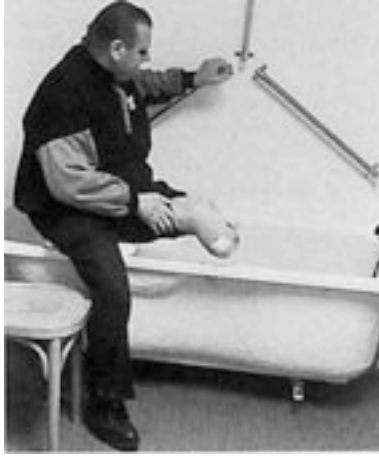
4 Cuarto de baño terapéutico: utilización de la bañera con un asiento y apoyos empotrados en la pared.
